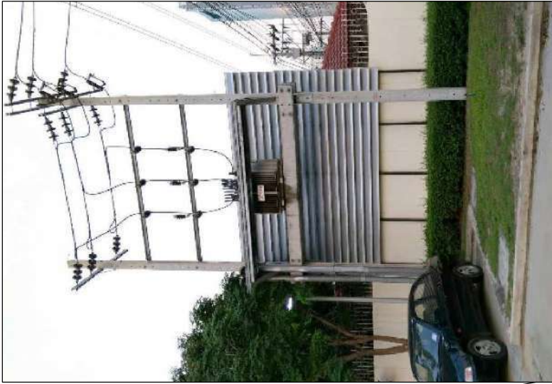
ตัวอย่างแผงกั้นบริเวณหม้อแปลงไฟฟ้า
