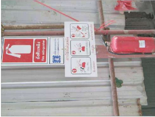
ถังดับเพลิงเคมีที่ติดตั้งด้านนอกอาคาร
